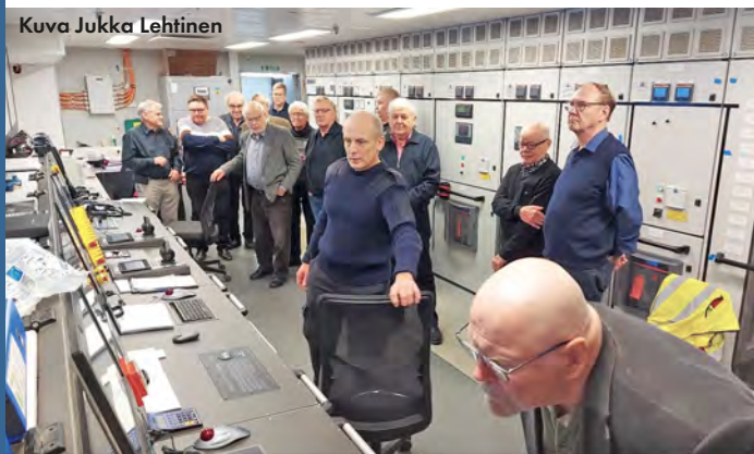
Kerhon jäsenet tutustuivat tarkasti Aurora Botnian konehuoneeseen
