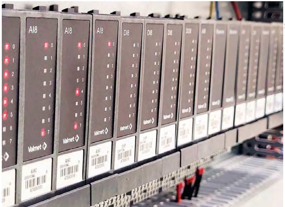
Laboratorion automaatiojärjestelmäksi valittiin Valmet DNA selainpohjaisella DNA UI käyttöliittymällä.
