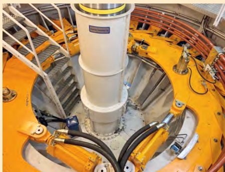
Kuvassa vettä turbiinin lapoihin päästävien johtosiivistön säätösyliinterit ja turbiinin akselisuoja putkiin. Kuva: Jukka Kauppinen
