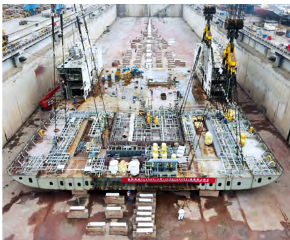
Finneco II -aluksen rakentaminen etenee ja kölinlohko laskettiin Nanjing Jinling -telakan rakennusaltaaseen.
