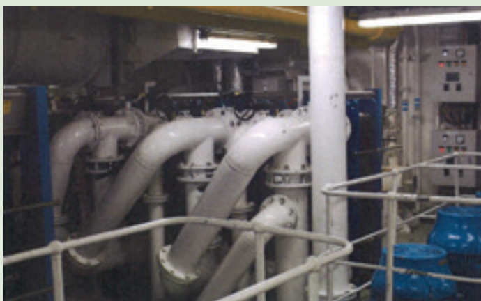
Här värms det flytande bränslet upp och omvandlas till gas.
