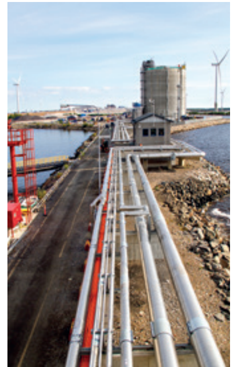
Lng-terminaalista johtaa suora putkiliinja Outokummun Tornion terästehtaalalle, sekä EPV Energian voimalaitokselle.
