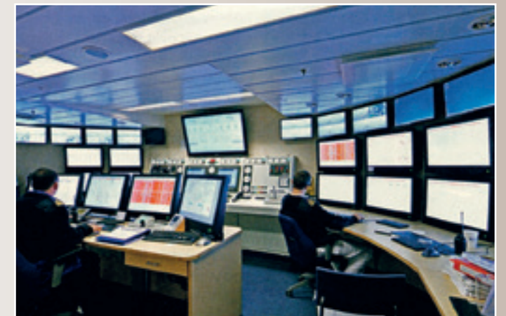
Oasis of the seas. Koneautomaation ohjaushuone. (Kuvat: Jouni Saariso)
