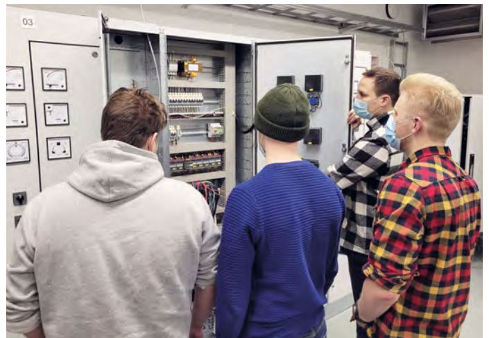
Sähkövoimatekniikan lehtori Kalle Suoniemi perehdyttää opiskelijoita kampusen laboratorioon rakennetun päätaulun toimintaan. (Opiskelijat vasemmalta: Arttu Haapsaari, Asko Kanerva ja Artturi Tolvi)
