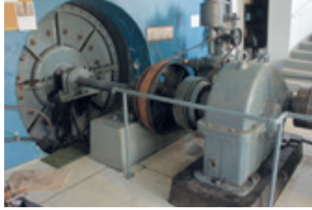
Vuonna 1953 rakennettu, 200 kW:n Tampellan Francis- vaakamalli solukkeidensäätäjäremmillä, hammasvaihte ja kytkin.
