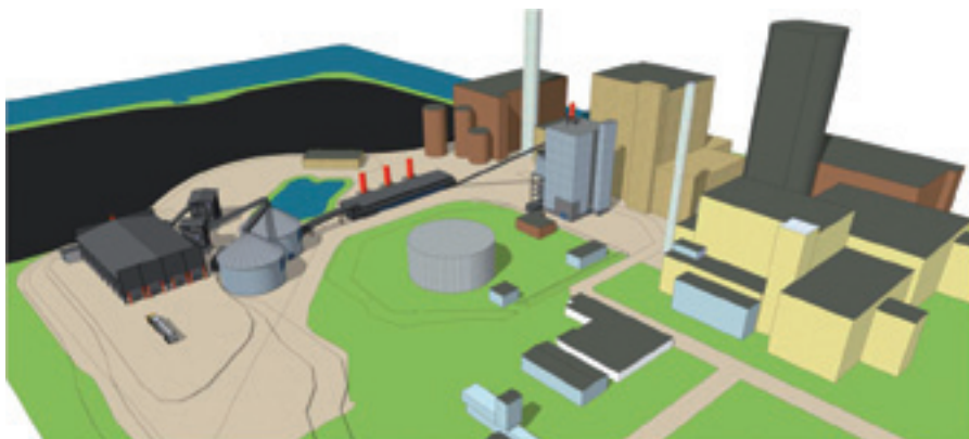
Havainnekuvan kuvateksti: Vaasan Vaskiluodon biomassan kaasutuslaitos edustaa uutta teknologiaa, jolla kivihiiltä voidaan nopeasti ja suhteellisen edullisesti korvata biopolttoaineilla hiilivoimalaitoksissa.
