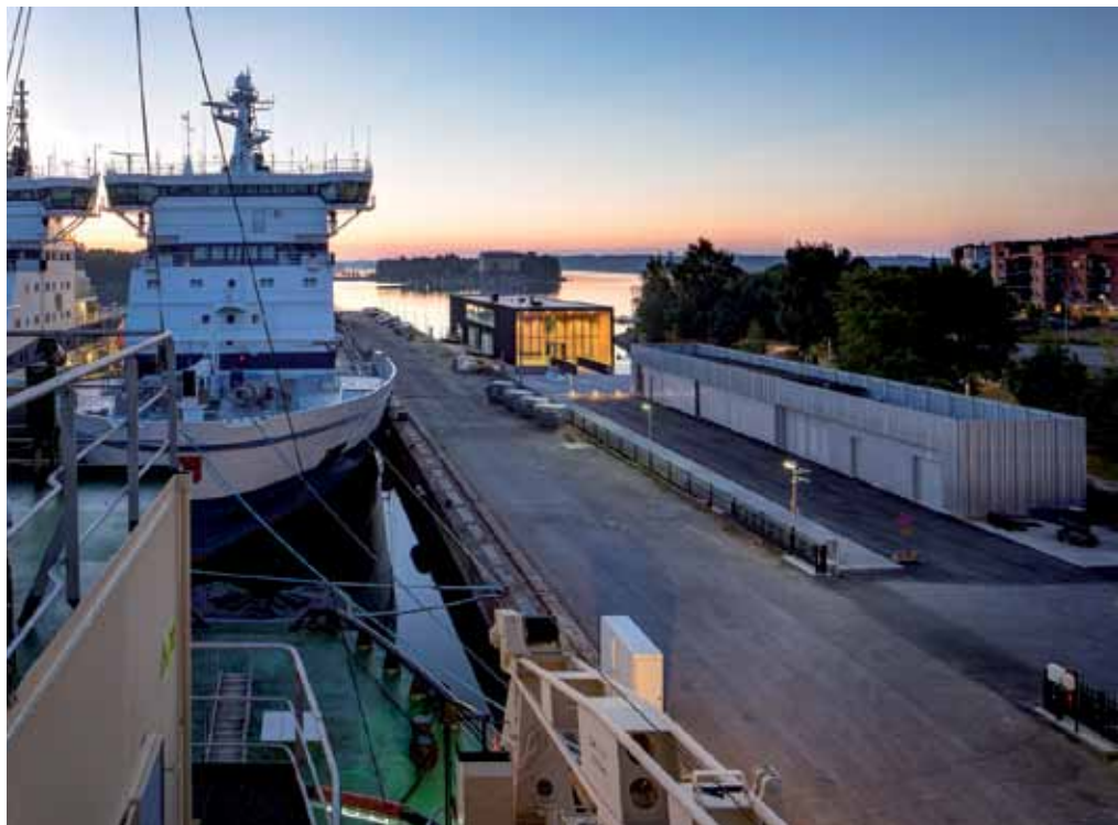
Uuden konttorirakennukset vieressä sijaitseva vanha huoltorakennus sai myös uuden verhouksen.
