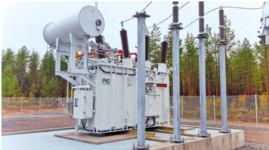
Päämuuntaja Järvi-Suomen Energian sähköasemalla.
