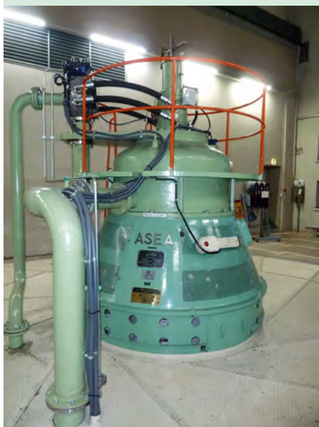
Vesiturbiinin öljynjakopesä.
