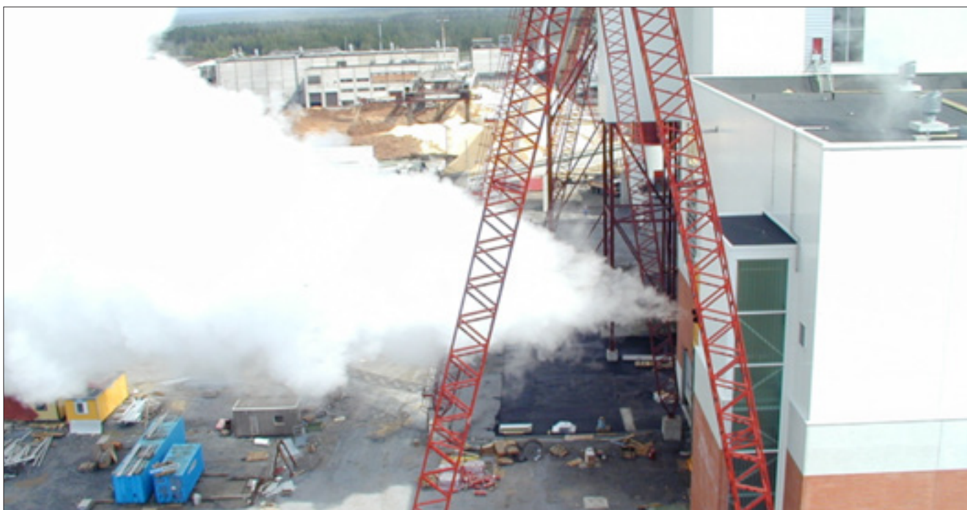
Ison höyrykattilan puhtaaksi puhallus asennustöiden jälkeen
