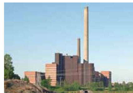
Salmisaaren sähkön- ja lämmöntuotantolaitos, lähde Helsingin Energia
