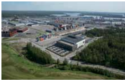
ABB:n Marine & Cranes -yksikkö Helsingin Vuosaarella kehittää sähköistys- ja automaattioratkaisuja meriteollisuuden tarpeisiin.
