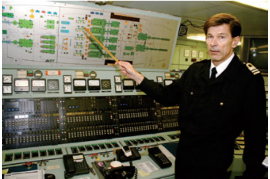
Urhossa on perinteisen mallinen konevalvontakeskus. Valvomosta näkee, että se on alun perin rakennettu aikaan ennen tietokoneita.
