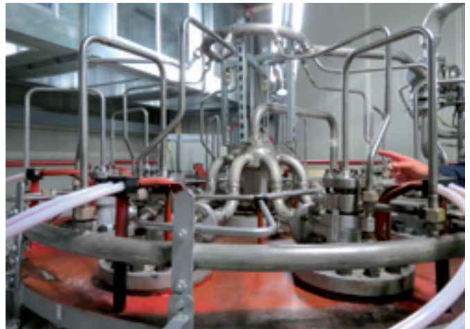
Polttokammion polttoainesyöttö
