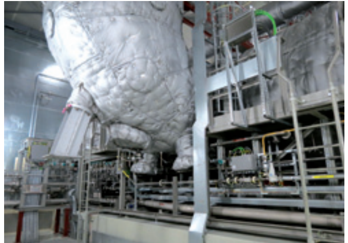
Toisen turbiinin toinen polttokammio ja osa turbiinia
