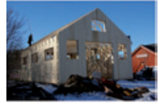
Arbetet med uppriktning av takstolar
