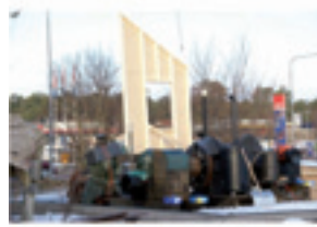
Första väggelementet lyfts på plats i Mars
