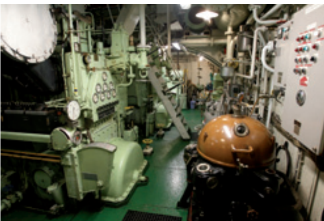
Sampom konehuoneen etuosa ja voiteluöljy- ja polttoaineseparaattori.
