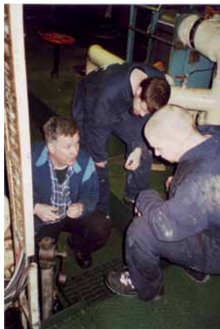
Hyvin suunniteltu on puoliksi tehty. Opettaja Kari Lehtinen tutkii yhdessä Kimmo Uutun ja Totti Mansokosken kanssa toppiputken korjausta.
